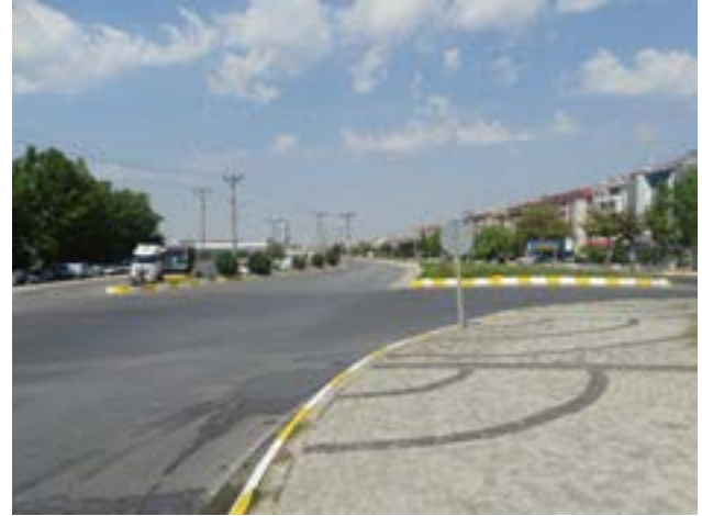
Fotoğraf 57 Şevki Arman ve Talat Paşa Caddeleri'nin kesişimi olan dönel kavşağın merkez ada çapı ve giriş çapı trafik akışında sapmalara neden olmamakta (EMBARQ Türkiye, 2015)
