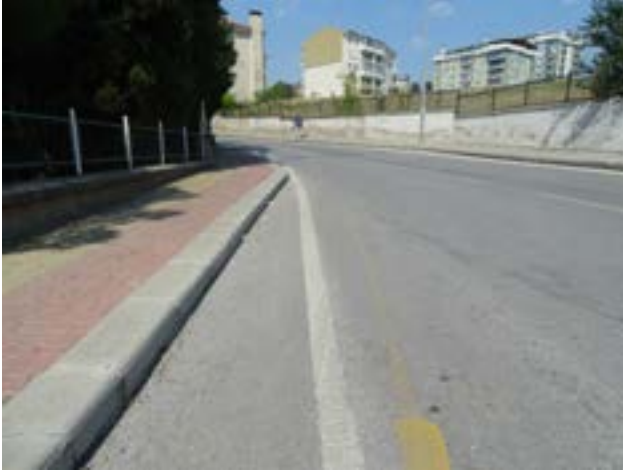
Fotoğraf 31 Motorlu taşıt platformu üzerinde kaybolan bisiklet yolu enkesiti (EMBARQ Türkiye, 2015)
