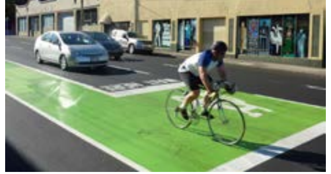
Şekil 93 Güvenli bisiklet altyapısına sahip kavşak tasarımındaki bisiklet bekleme alanı
