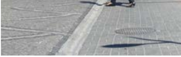
Fotoğraf 74 Yaya altyapısı ile bisiklet yolu arasındaki drenaj (EMBARQ Türkiye, 2015)
