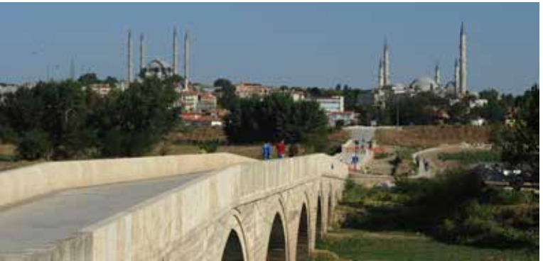
II. Bayezid Külliyesi'ni Tunca Nehri üzerinden şehir merkezine bağlayan II. Bayezid Köprüsü
