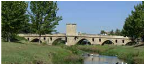
İlçe girişinde yer alan Babaeski Köprüsü
