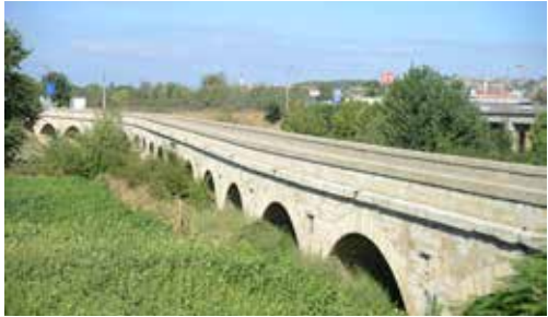
Gazi Mihal Köprüsü
