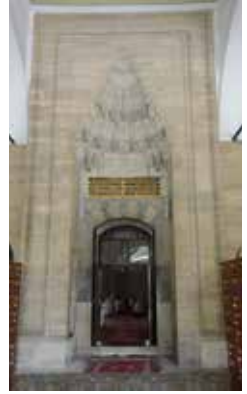
Rüstem Paşa Camii'nin giriş kapısı
