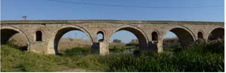
Tekirdağ yolu üzerinde yer alan Hacılar Köprüsü
