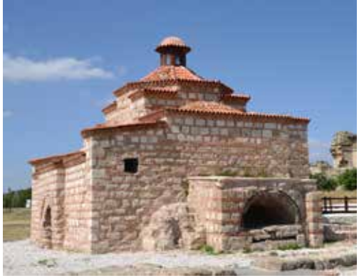
Restorasyonu tamamlanan Kum Kasrı Hamamı
